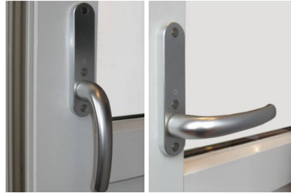
Ovijarru on päällä, kun ulkopuolinen painike on pystyasennossa.
