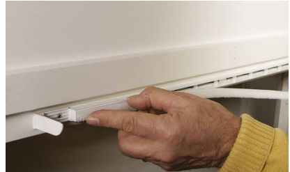
Elektrostaattisen allergeenisuodattimen vaihto
