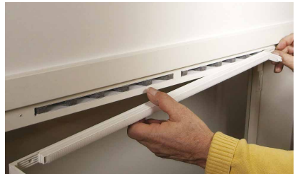
Ilmanotokanavat suodatinkehksen takana
