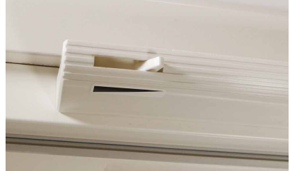
Ilmämääräsäädin on manuaalinen.
